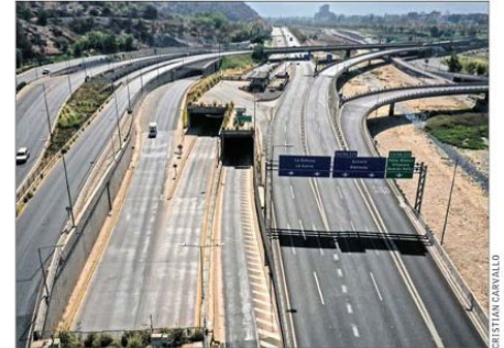
El flujo de vehículos en las carreteras urbanas ha caído fuertemente por las cuarentenas y el teletrabajo.
