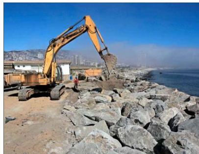
OBRAS. — Un proyecto de protección costera ante el incremento de las marejadas se desarrolla en el sector Edwards-Barón, de Valparaíso.
