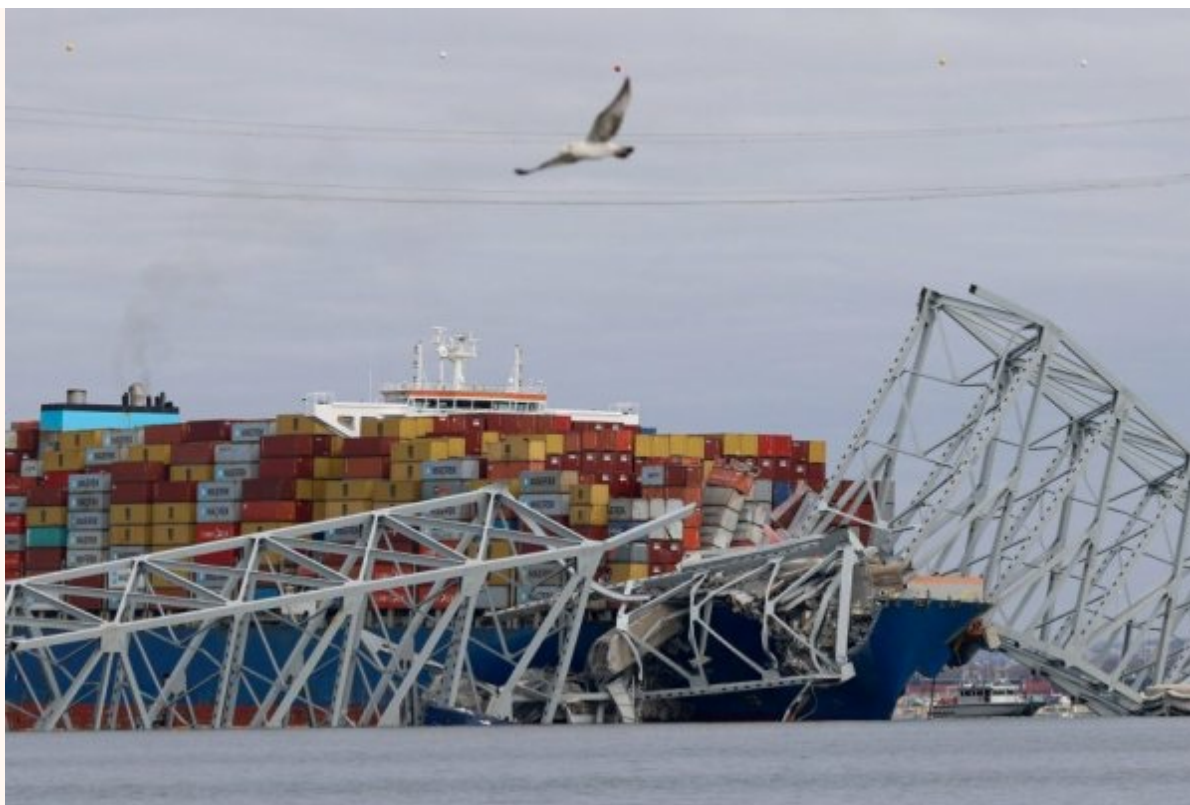
Barco derrumba el mayor puente de Baltimore.
